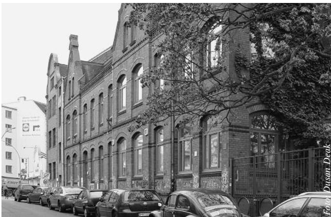
Das bisherige Gemeindehaus in der Eifflerstraße 3
